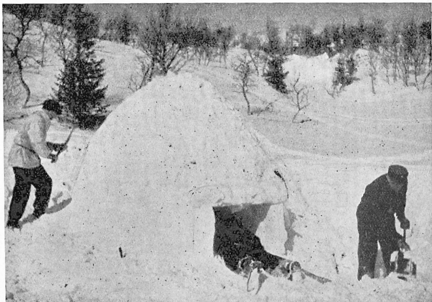
När igloon är täckt, tätas den med snö utifrån och tages i besittning. Förf. foto.
