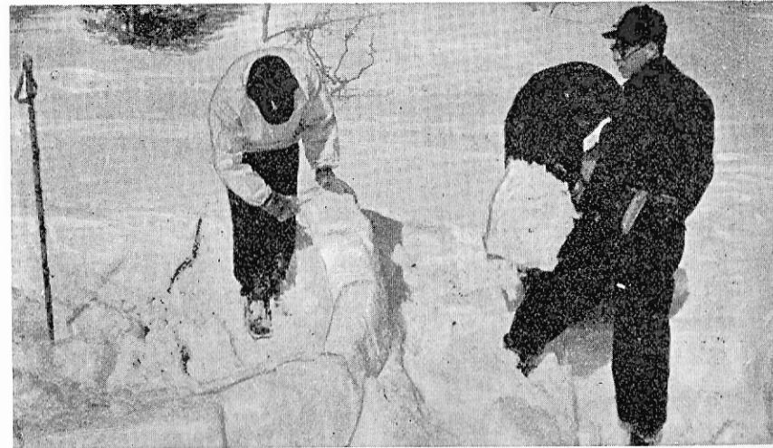
Andra varvet nyss påbörjat. En man skär till blocken, en bär fram dem och en murar. Staven markerar centrum.
