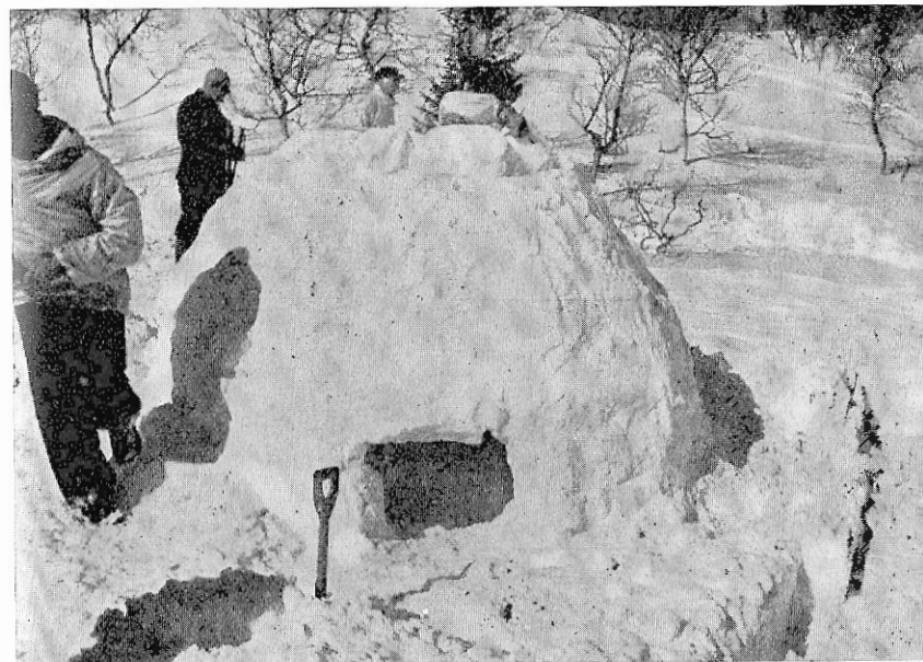
Högst upp måste blocken givas stark lutning inåt, för att igloon ej skall bli för hög. Förf. foto.
