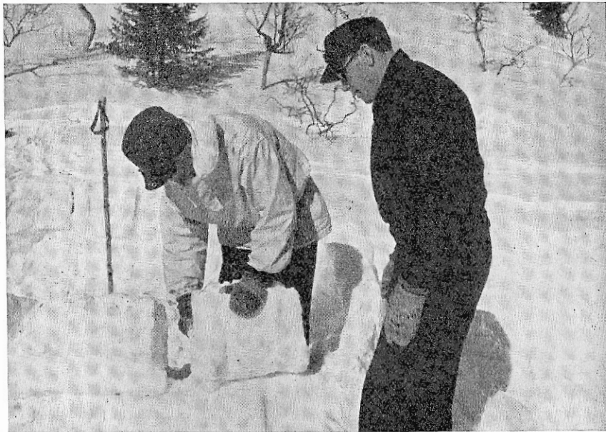
Fogarna skäras noggrant samman med kniven, varvid de göras sneda. Förf. foto.
